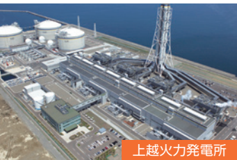
上越火力発電所
