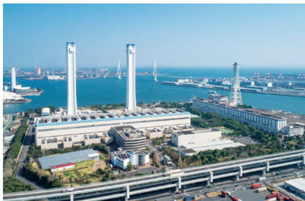
横浜火力発電所
