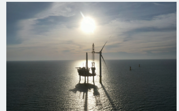
当社が参画する台湾のフォルモサ1洋上風力発電事業の建設時の様子 © Formosa I Wind Power Co., Ltd. All rights reserved.
