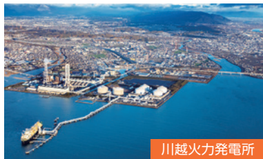
川越火力発電所
