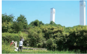
横浜火力発電所
