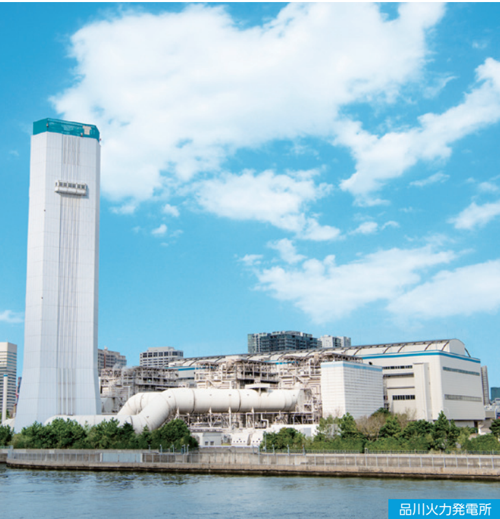
品川火力発電所
