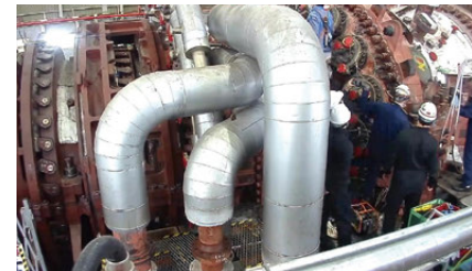
設備点検の様子
