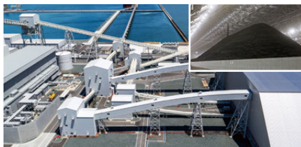
(中央)密閉式ベルトコンベヤ (右)屋内式貯炭場
