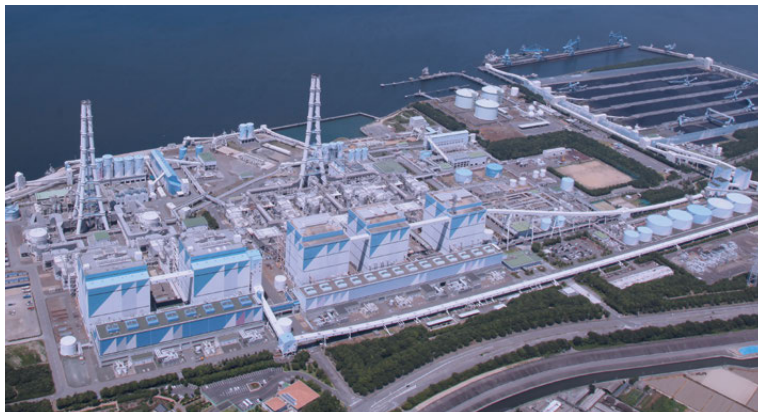
国内最大の石炭火力である碧南火力発電所(愛知県碧南市)では2023年度から20%のアンモニア混焼試験の開始を予定
