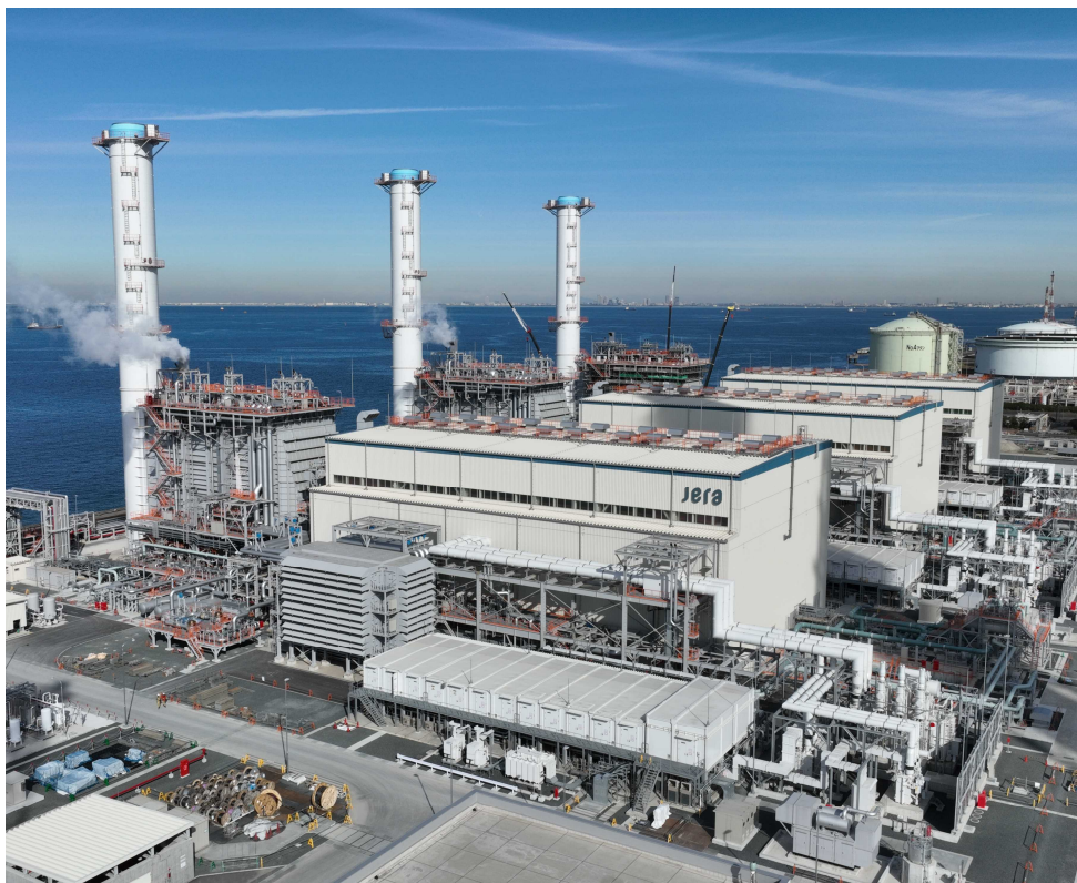
姉崎火力発電所
