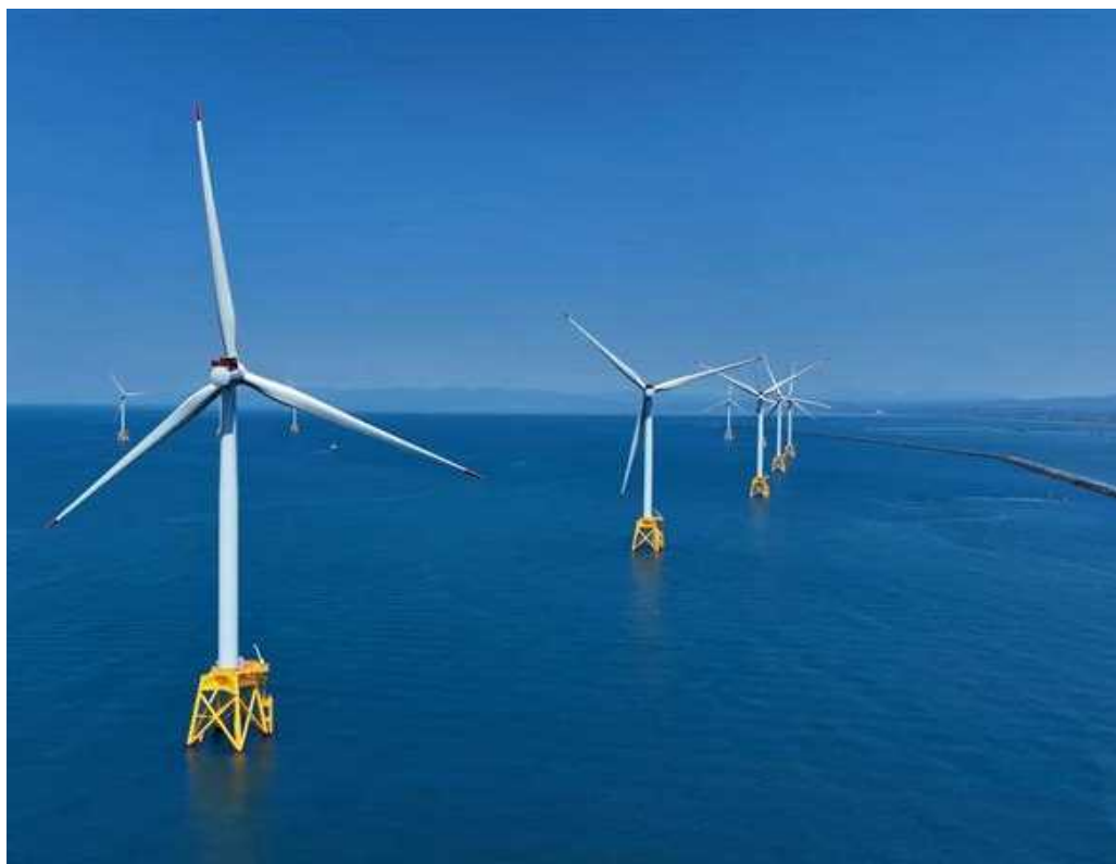
石狩湾新港洋上風力発電所
