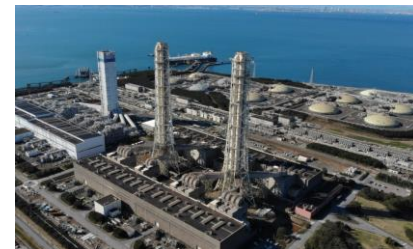
当社火力発電所（上空写真）
