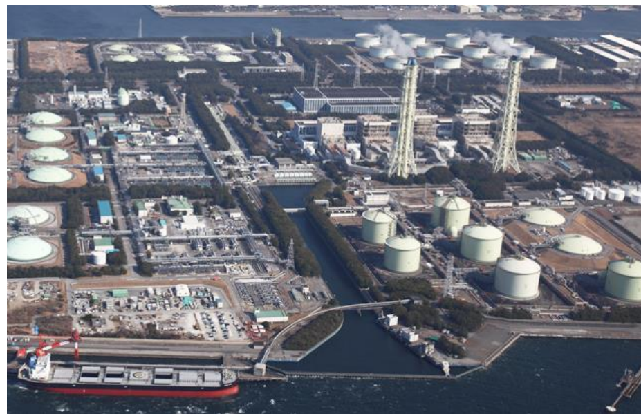
袖ヶ浦火力発電所(1番左側が1号機)
