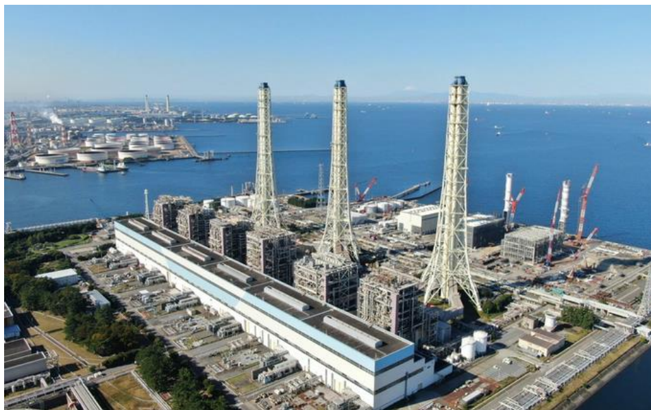
「2021年度冬季追加供給力の公募」を落札し、供給力として需給に貢献した姉崎火力発電所(右から2番目が5号機)
