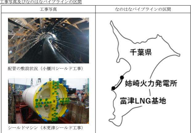
※ シールド工法:河川横断等、掘削が困難な箇所を施工する方法であり、トンネルを築造しその中に ガス管を敷設する。
