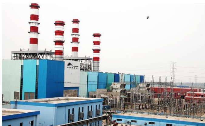
メグナハット発電所（出典：サミット・パワー社）
