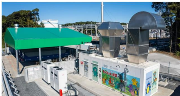
袖ヶ浦火力発電所（千葉県袖ヶ浦市）構内に設置した水素発電機
