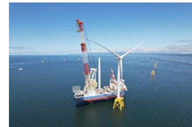
〈タービン発電機設置工事〉
