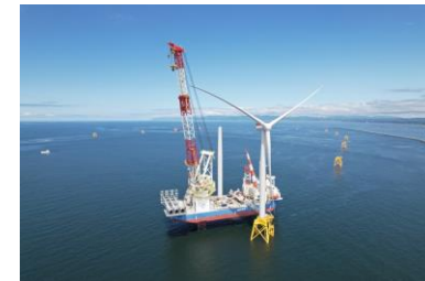
〈タービン発電機設置工事〉
