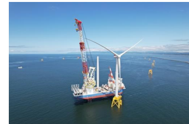
〈タービン発電機設置工事〉
