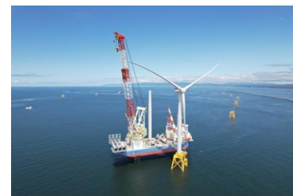
〈タービン発電機設置工事〉
