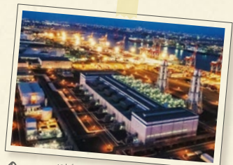
西知古屋火力発電所
