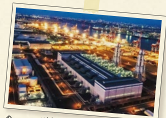
西名古屋火力発電所
