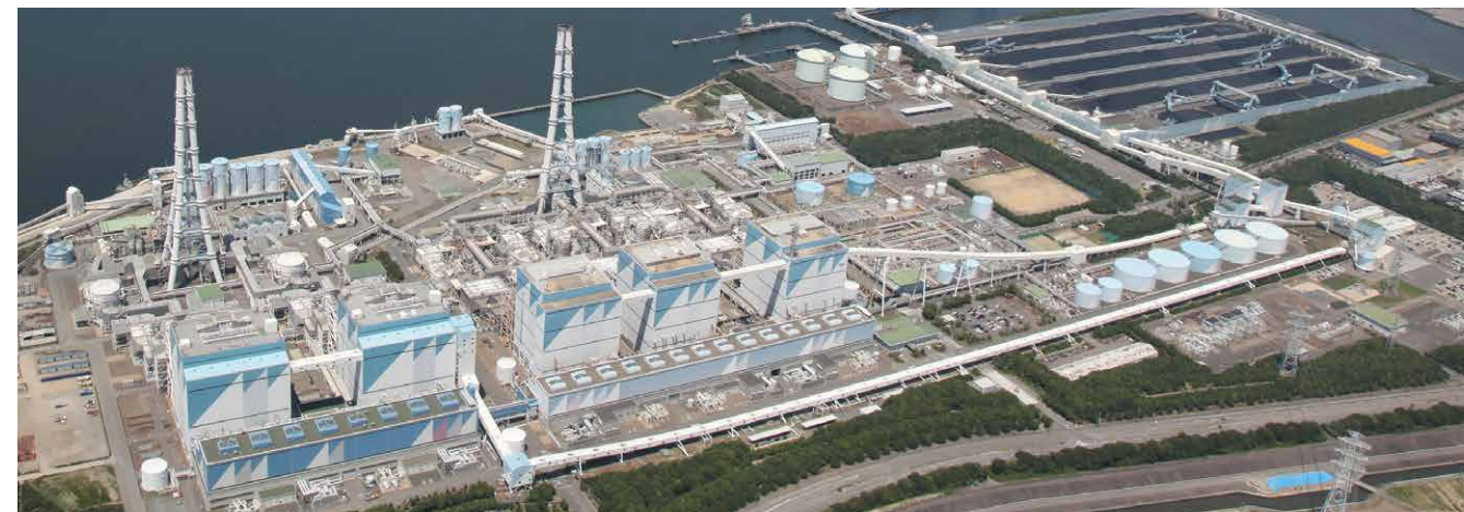
アンモニア混焼に関する実証事業を行う碧南火力発電所(愛知県)
