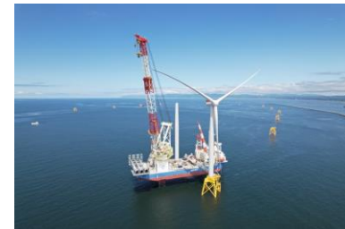
〈タービン発電機設置工事〉
