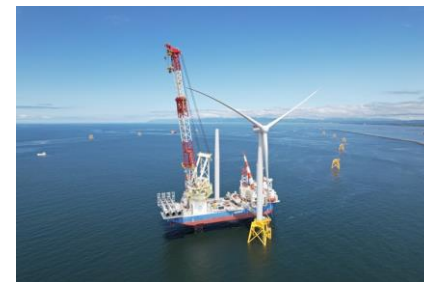
〈タービン発電機設置工事〉
