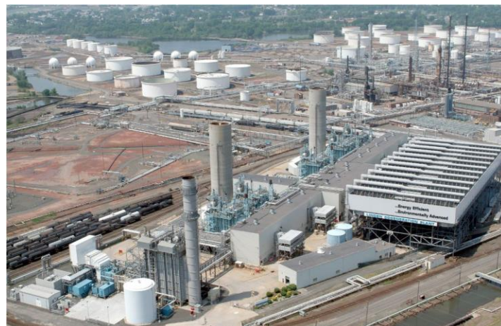
リンデンガス火力発電所
