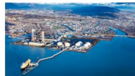
川越火力発電所
