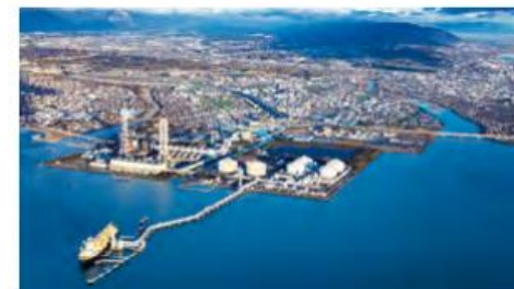
川越火力発電所
