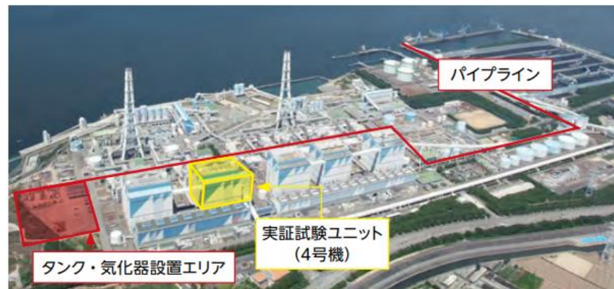
碧南火力発電所
