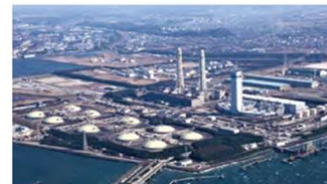
富津火力発電所
