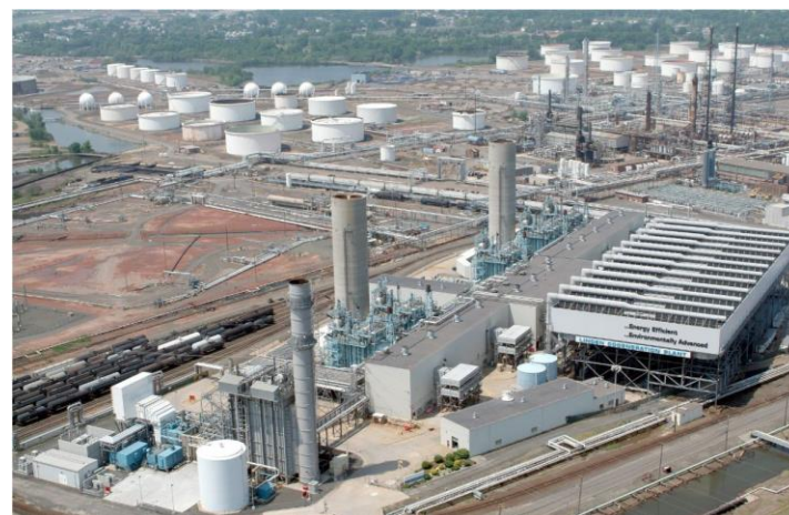
リンデンガス火力発電所
