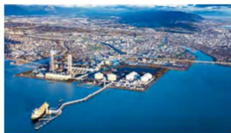
川越火力発電所
