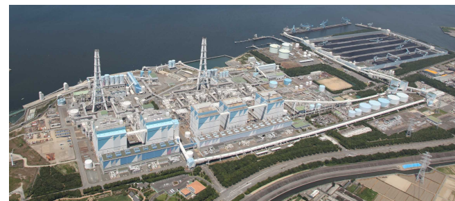
実機においてアンモニア混焼実証を行う予定の 碧南火力発電所
