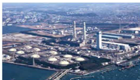
富津火力発電所
