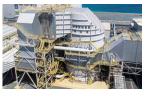
排煙脱硫装置(硫黄酸化物(SOx)の除去)
