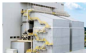
排煙脱硝装置(窒素酸化物(NOx)の除去)
