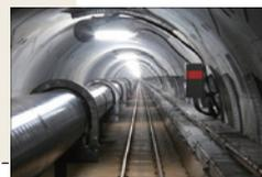
「東西関係ガス導管」の海底ガス導管
