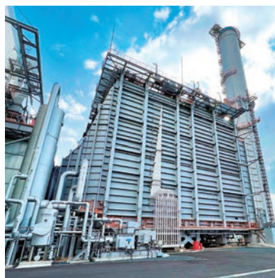
排煙脱硝装置（窒素酸化物（NOx）の除去）
