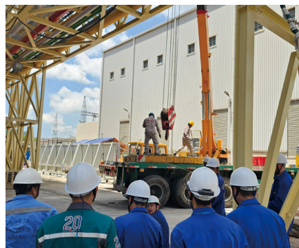
メコンエナジー社フーミー2.2発電所（ベトナム）における安全パトロールの状況
