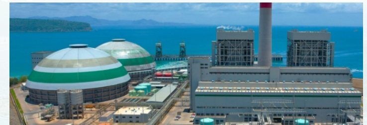
Aboitiz Powerが出資参画するGNPD発電所
