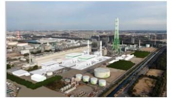
次期地点としては、知多火力発電所7・8号機の建設を、東邦ガス株式会社とともに、知多エナジーソリューションズ合同会社を通じて進めることを意思決定しており、2029年度の運転開始を目指して各種準備を進めてきました。LNGを燃料とするGTCC設備で、7・8号機合計の出力は約132万kWを計画しています。
