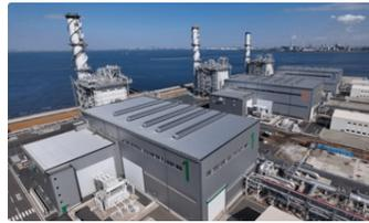
本発電所は、天然ガス(LNG)を燃料とし、最新鋭の燃焼温度1,650℃級ガスタービンを用いた、ガスタービン・コンバインドサイクル方式(GTCC)を採用しています。3号機の営業運転開始により、五井火力発電所合計の出力は234万kWとなり、安定した電力供給に貢献できるものと考えています。
