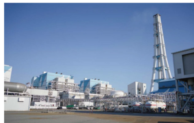
アンモニア転換商用運転を実施するJERA碧南火力発電所(愛知県)
