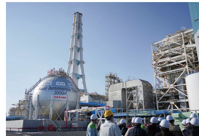
碧南火力発電所
