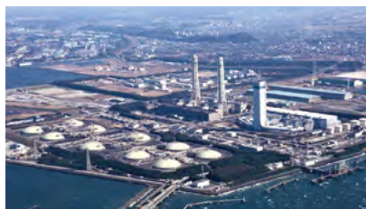
富津火力発電所
