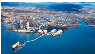
川越火力発電所
