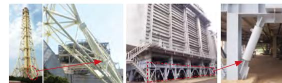
姉崎火力発電所 煙突耐震補強 富津火力発電所 HRSG耐震補強
