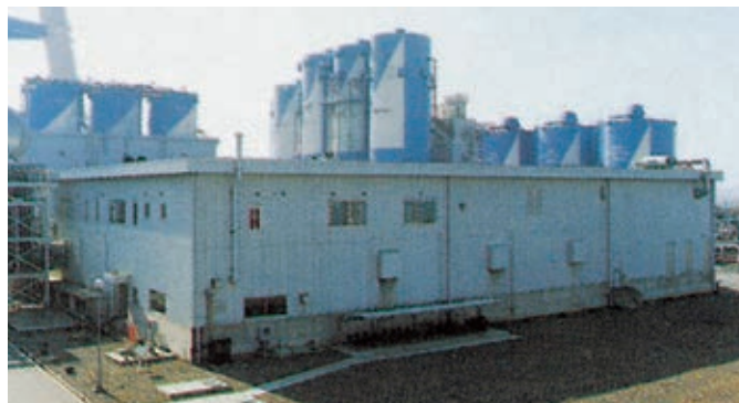
排水処理設備、灰処理設備の操作監視を行う環境設備制御室。 この他に揚貯運炭設備の操作監視を行う運炭制御室を設けています。
