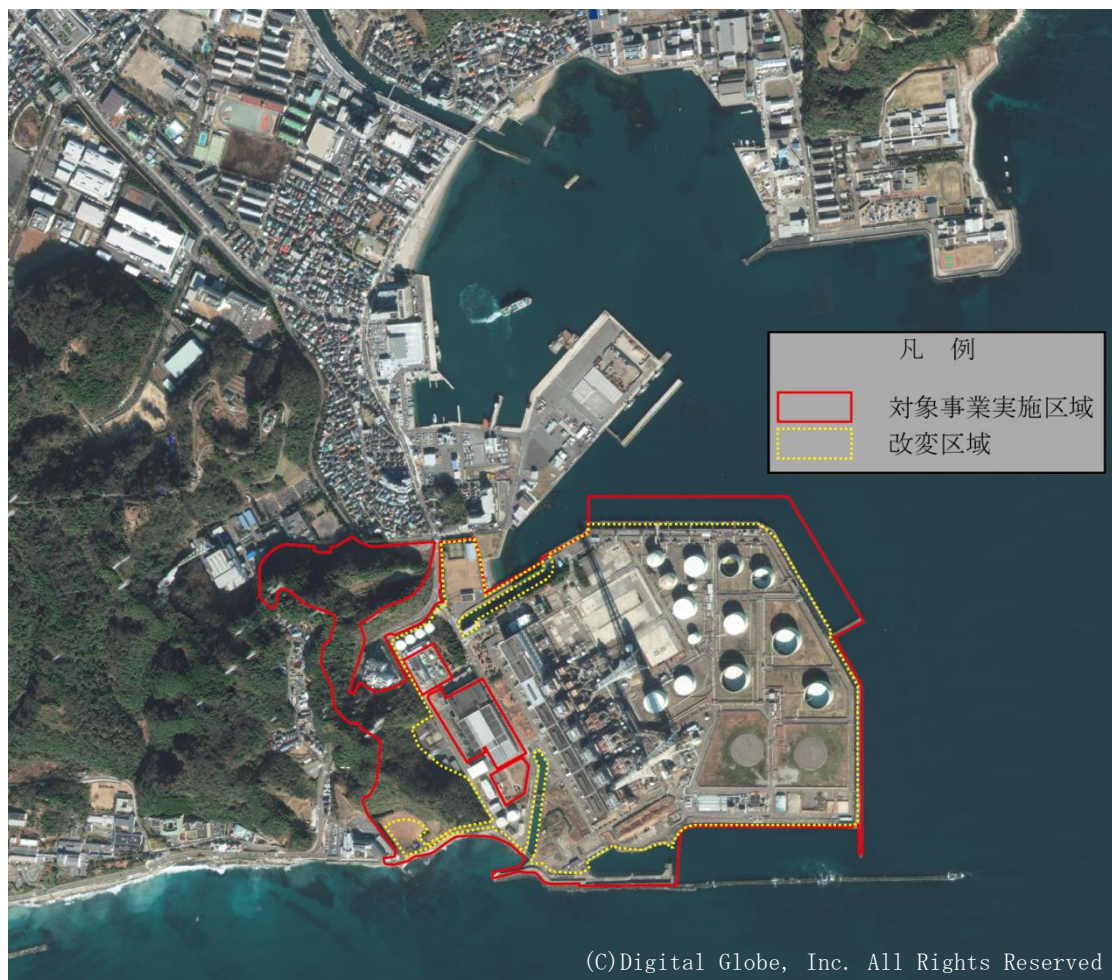
第4図 発電所の設置予定地及びその周辺の状況
