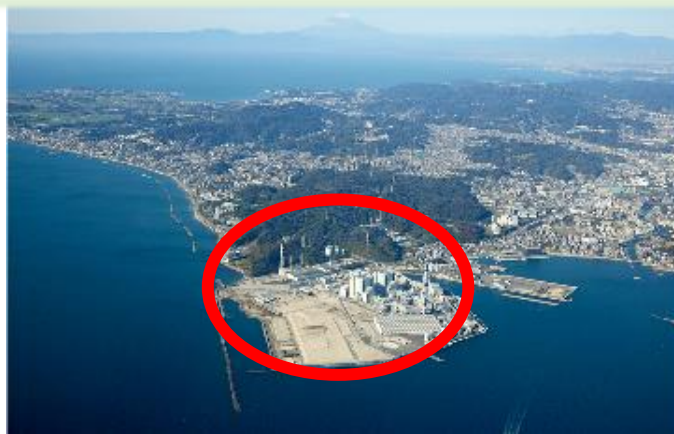
横須賀火力発電所全景
