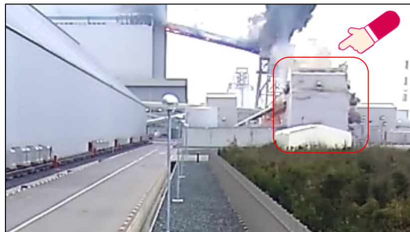
【延焼】 約18分後、中継タワーJT7へ延焼
