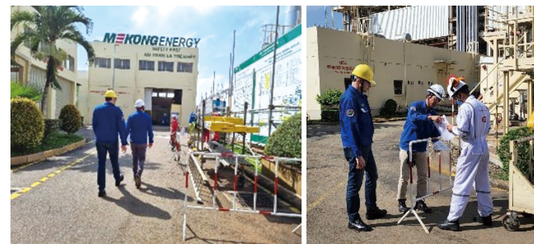
メコンエナジー社フーミー2.2発電所(ベトナム)における安全パトロールの状況
