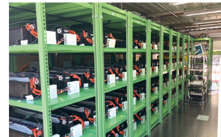
電動車用バッテリーを使用した大容量スイープ蓄電システム
