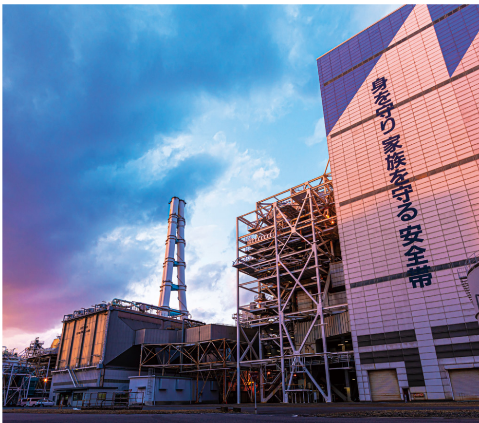
2023年度にアンモニアの実機実証試験の開始を予定している碧南火力発電所(愛知県碧南市)。現場では、安全を最優先に安全帯(墜落抑止用器具)などの装着を徹底している。
