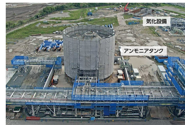
アンモニア実機実証試験に向けた設備工事が進捗する碧南火力発電所
