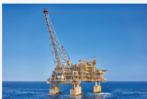
豪・ウィットストーンLNG事業 出典:Chevron Australia
