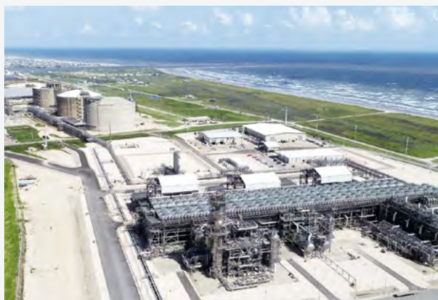
Freeport LNG Project liquefaction facilities Photo by Freeport LNG Development
